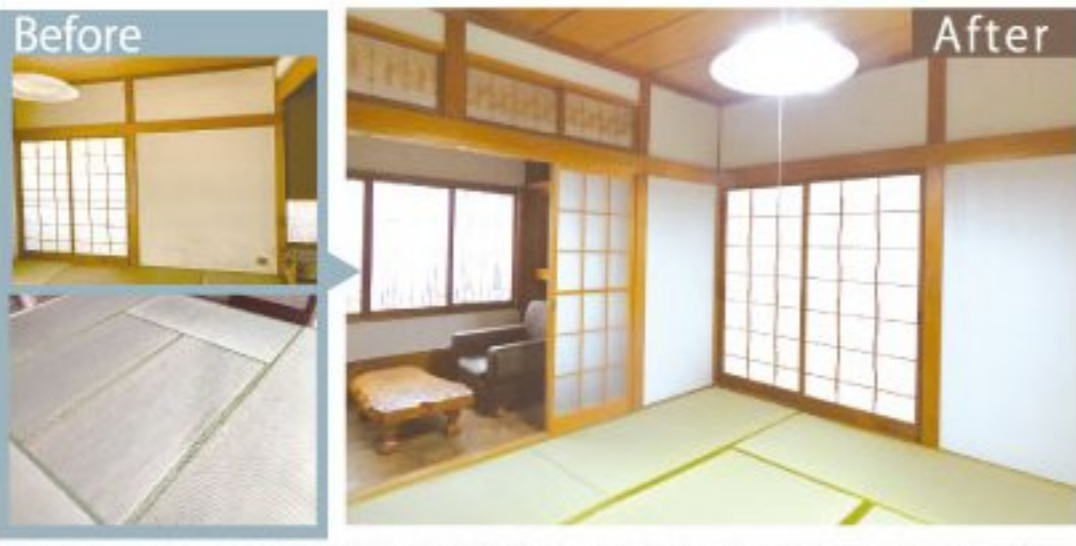
黒ずんでいた壁を塗装し白色に仕上げ、畳も表替えてきれいに
