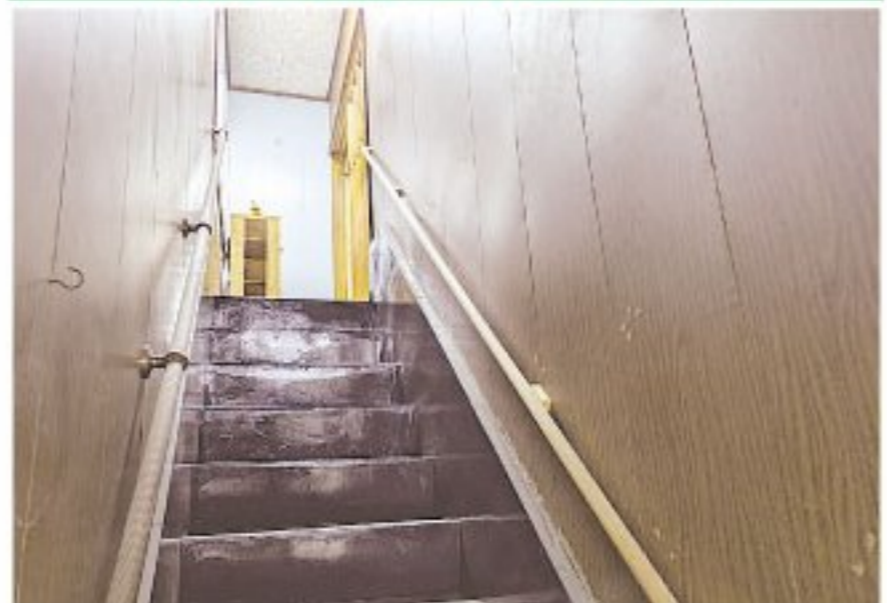
壁には施工写真を「Before」「After」で紹介予定
